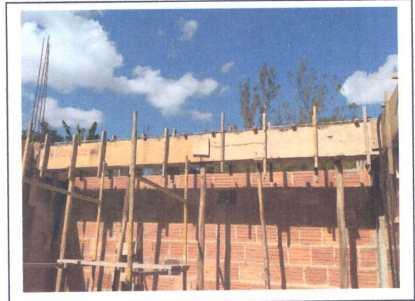
MONTAGEM DAS FORMAS, CINTAMENTO
