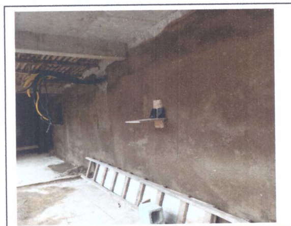
ALVENARIA E ESTRUTURA
