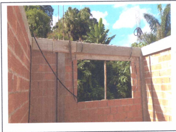
MONTAGEM DAS FORMAS, CINTAMENTO
