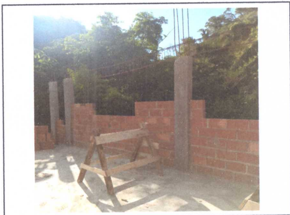
ALVENARIA E ESTRUTURA
