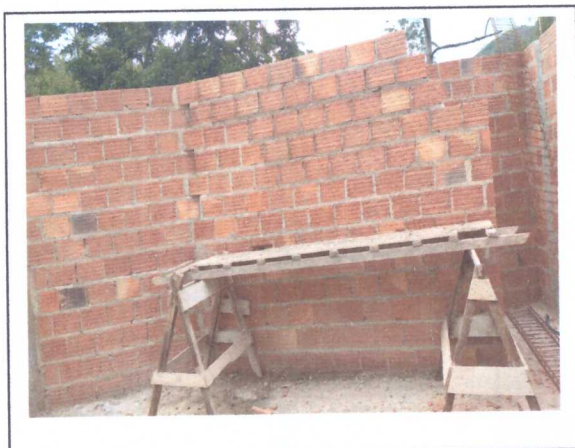
ALVENARIA E ESTRUTURA
