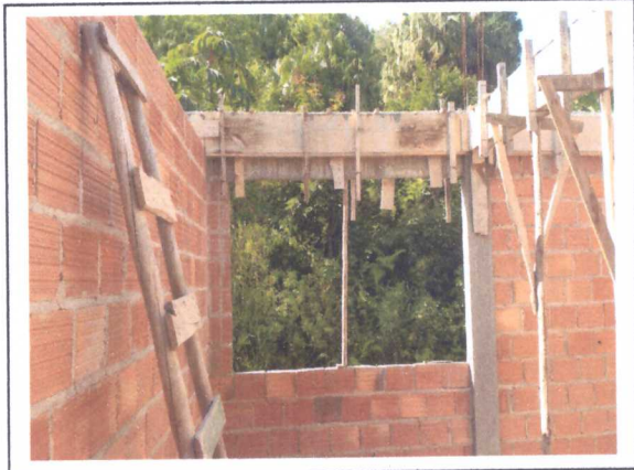
MONTAGEM DAS FORMAS, CINTAMENTO
